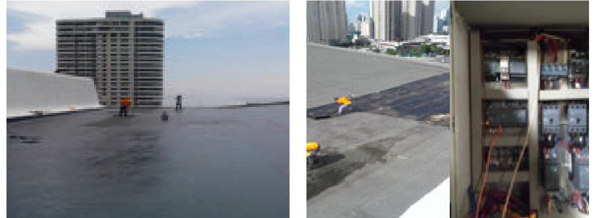
Trabajos de reparación en el Centro de Convenciones ATLAPA.
