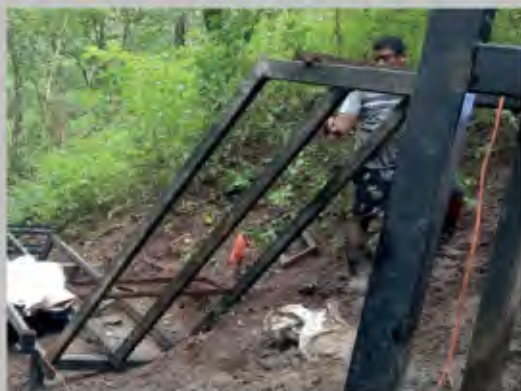
Construcción de estructura de puente colgante
