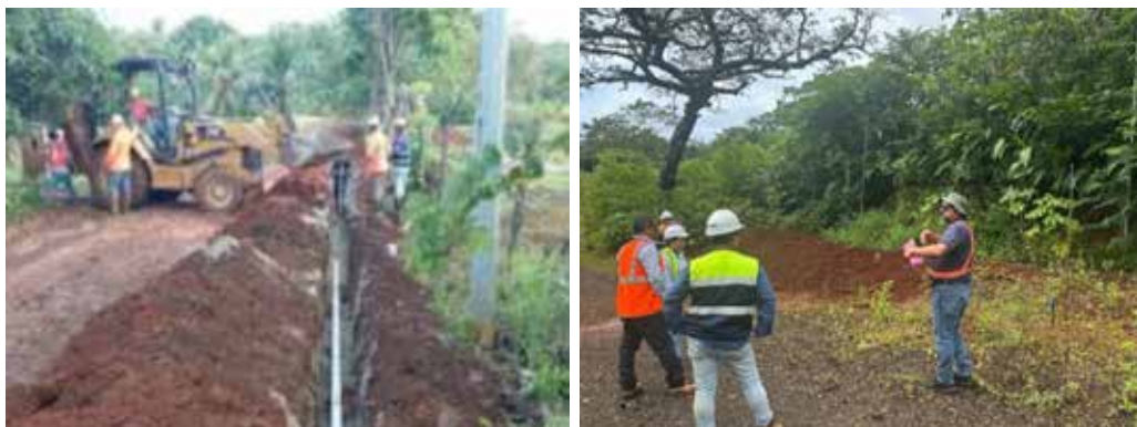
Instalación de tuberías para la línea de conducción.
