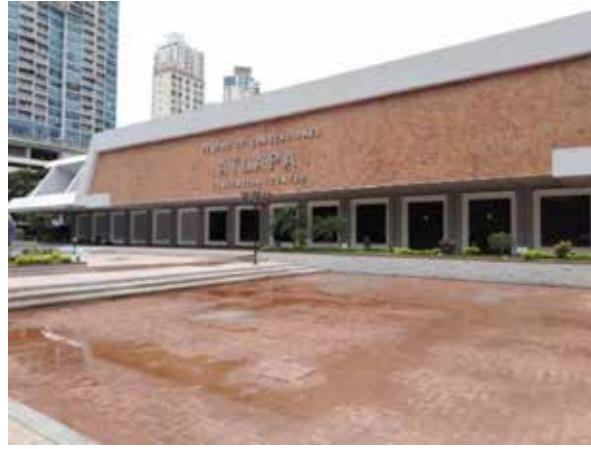
Reparación de pisos externos.
