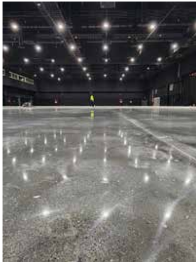
Mejoras a Pisos y Luminarias del Salón Las Islas.
