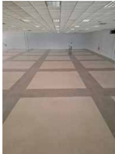
Mejoras piso y cielo raso Salón La Totuma.
