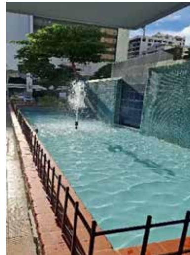
Reparación de fuentes de agua.
