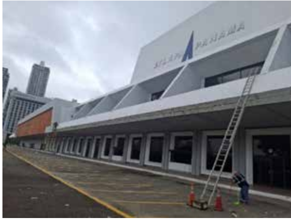
Pintura Externa y Reparación de Aleros.
