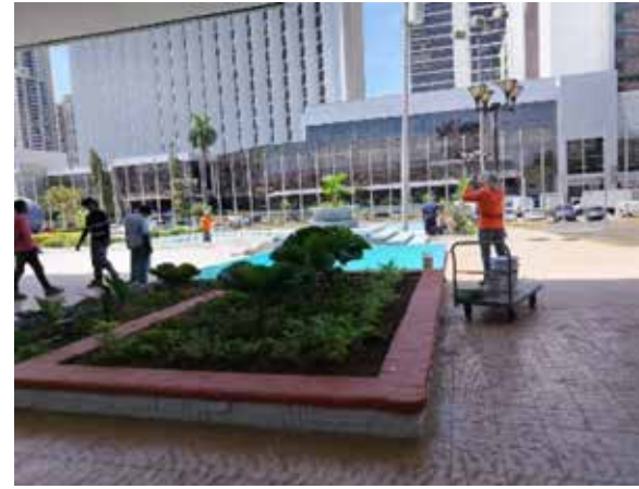
Reparación de pisos externos, fuentes y mejoras a jardines.
