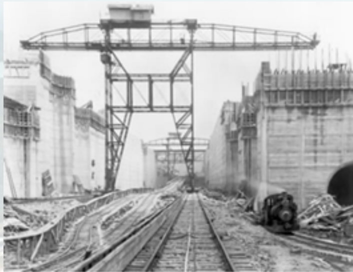
Esclusas en construcción
